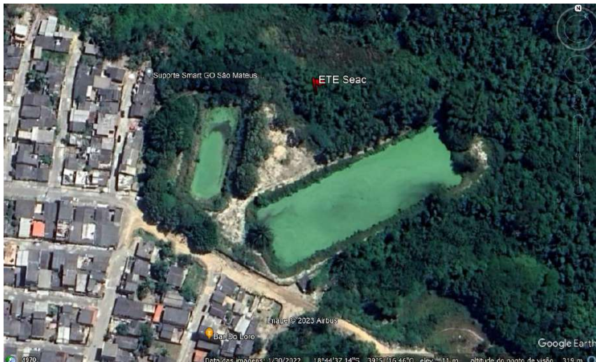
Figura 194 – Vista aérea da ETE SEAC. Fonte: Biancade Engenharia
