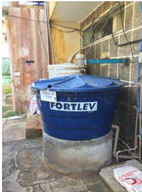
Figura 64 - Tanque de Flúor. Fonte: PMSB, 2019.
