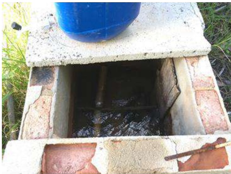
Figura 127 - Canal de Chegada de Água Bruta – Sistema Km 35. Fonte: PMSB, 2019.
