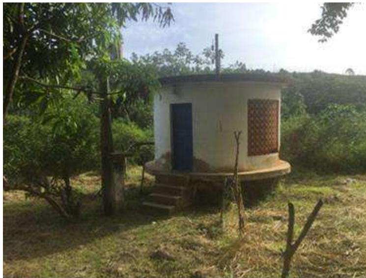
Figura 147 - Nascente de Captação – Sistema Itauninhas. Fonte: PMSB, 2019.
