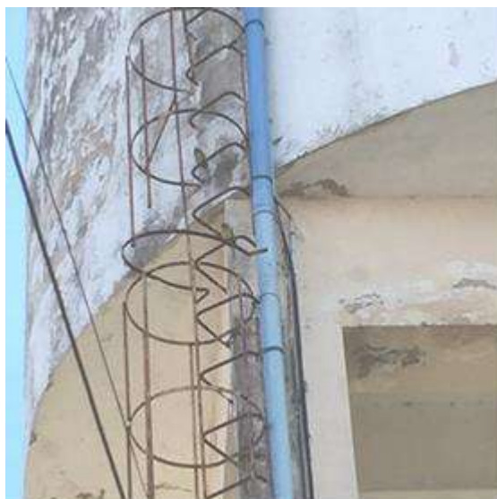
Figura 75 - Reservatório Sernamby: Escada deteriorada. Fonte: Biancade Engenharia, 2023.
