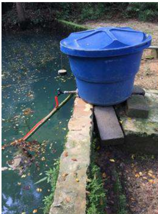
Figura 137 - Desinfecção com Cloro – Sistema Km 41. Fonte: PMSB, 2019.
