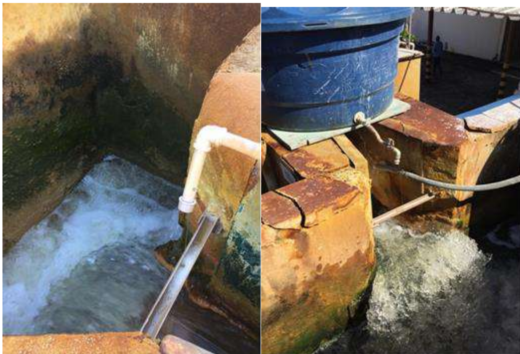
Figura 55 - Adição de Coagulante - ETA's 1 e 2. Fonte: Biancade Engenharia, 2023.
