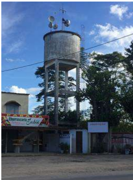
Figura 139 - Reservatório – Sistema Km 41. Fonte: PMSB, 2019.
