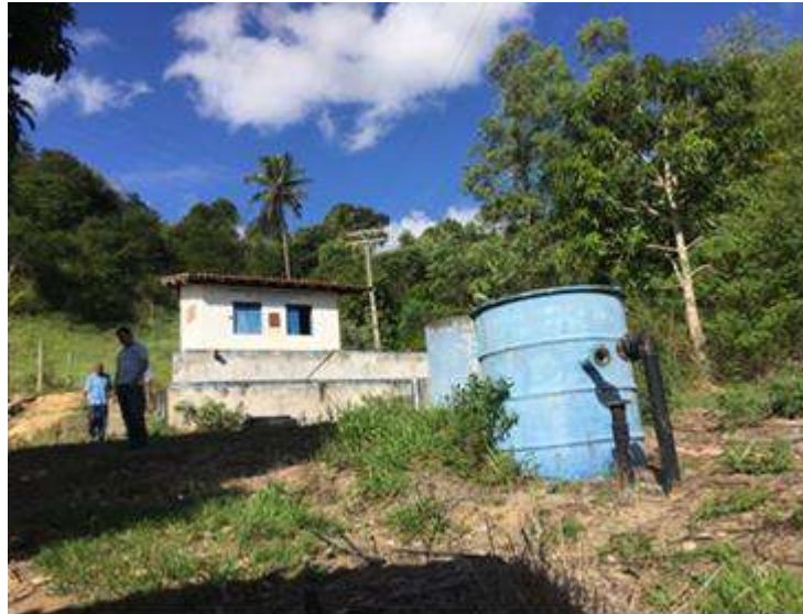
Figura 129 - Vista 2 ETA – Sistema Km 35. Fonte: PMSB, 2019.
