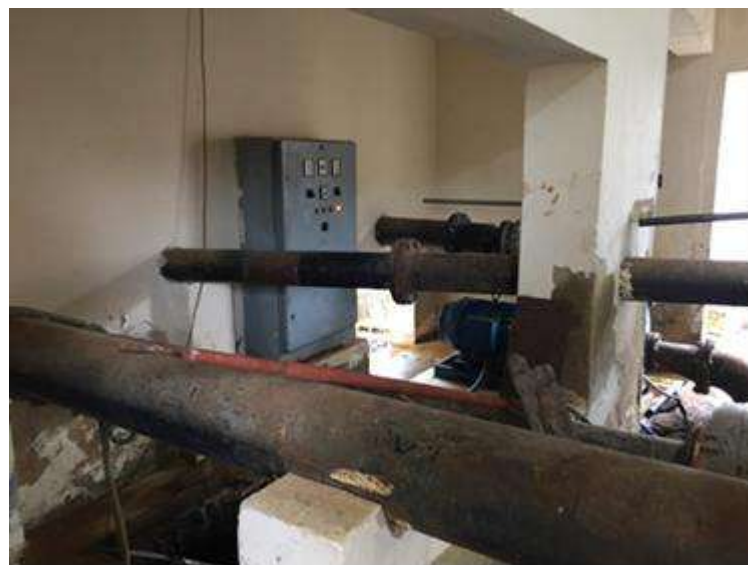
Figura 97 - Quadro de Comando - ERAT ETA Guriri. Fonte: PMSB, 2019.
