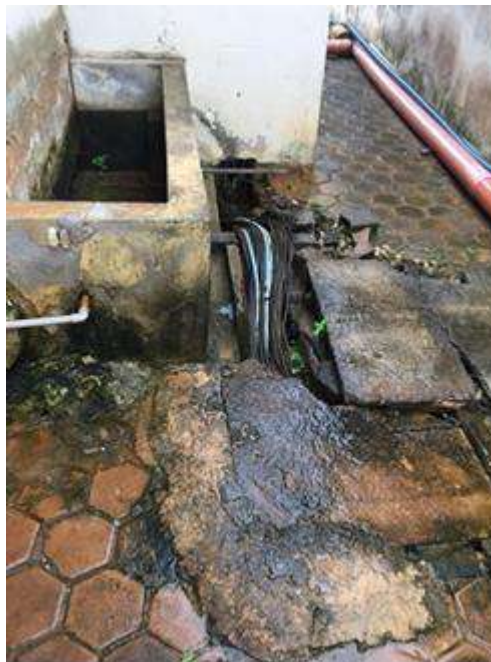
Figura 91 - Fiação aparente na ETA. Fonte: PMSB, 2019.
