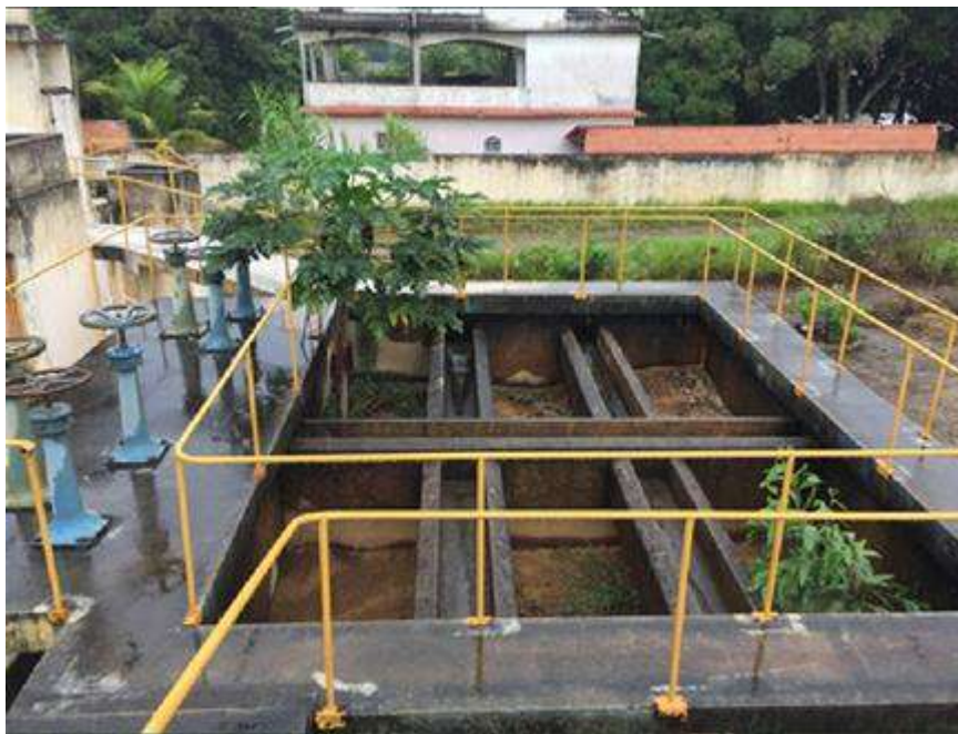
Figura 87 - Caixa de Chegada e Calha Parshall (inoperantes). Fonte: PMSB, 2019.
