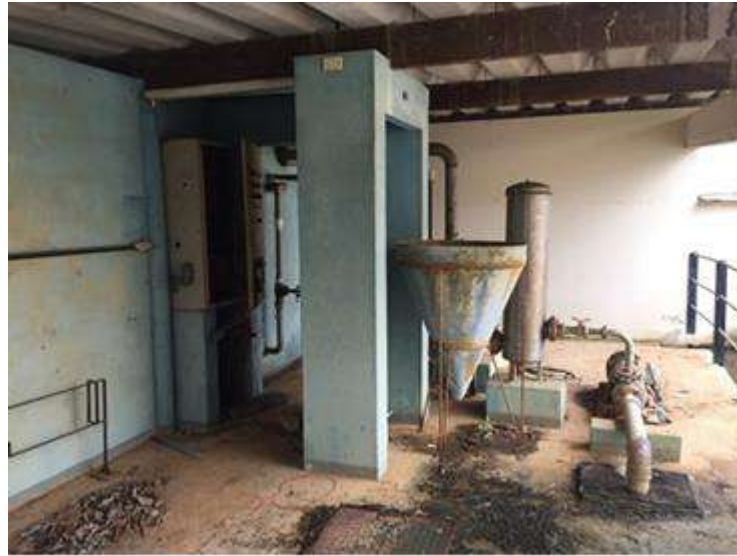
Figura 93 - Vista 2: Dessalinizador. Fonte: PMSB, 2019.
