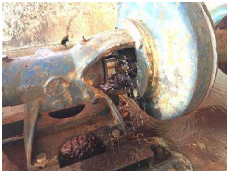
Figura 186 - Vazamento no Recalque de Água Tratada – Sistema Km 35. Fonte: PMSB, 2019.
