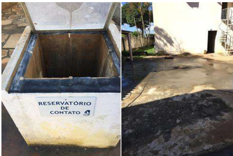
Figura 66 - Tanque de Contato. Fonte: PMSB, 2019.
