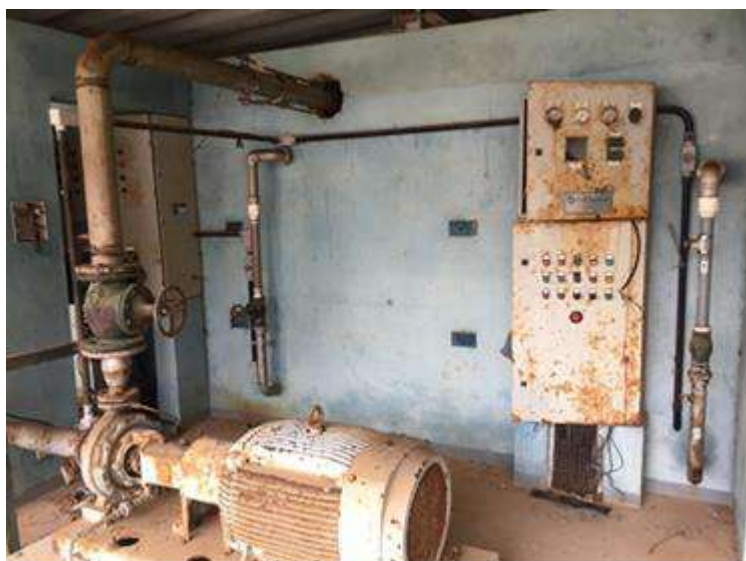
Figura 95 - Conjunto Motobomba e Quadro de Comando - Dessalinizador. Fonte: PMSB, 2019.
