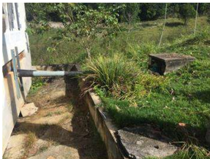
Figura 158 - Poço Raso – Sistema Nova Vista. Fonte: PMSB, 2019.
