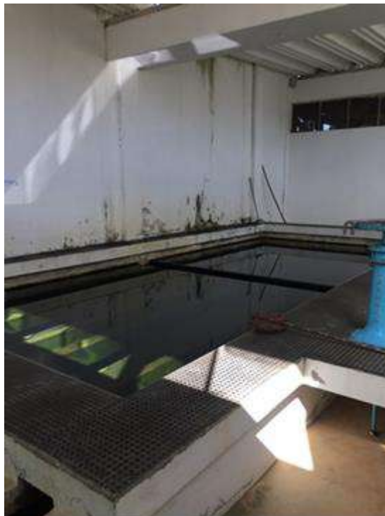
Figura 59 - Filtro Ascendente ETA 1. Fonte: PMSB, 2019.
