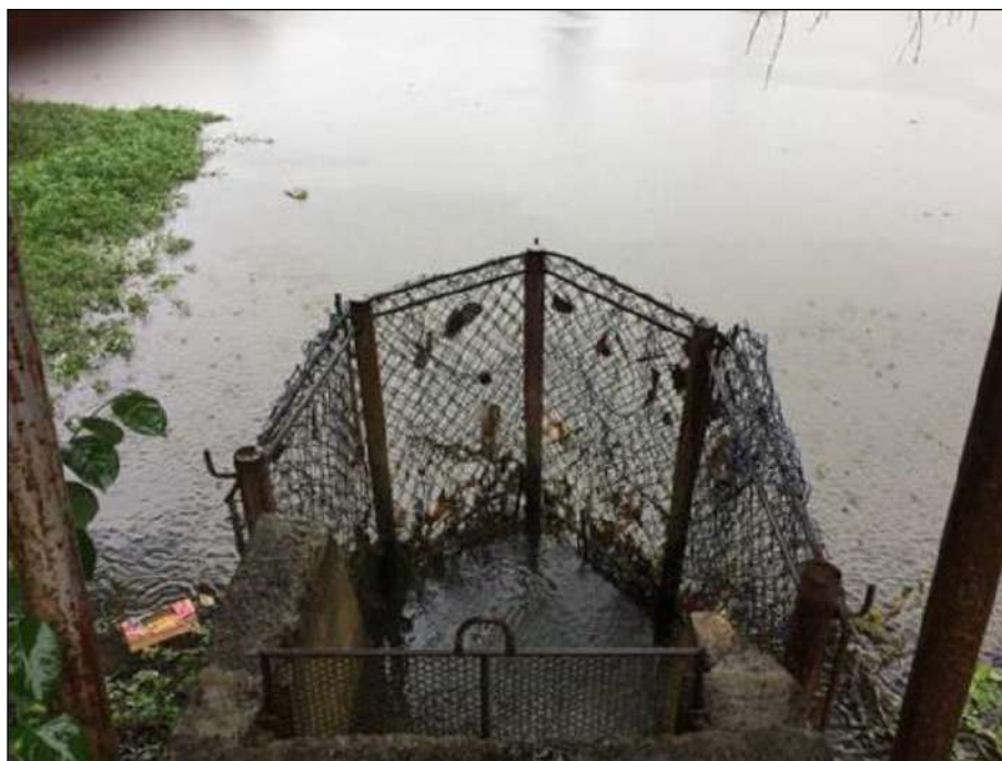
Figura 28 -- Tela Proteção Canal de Captação. Fonte: PMSB, 2019
