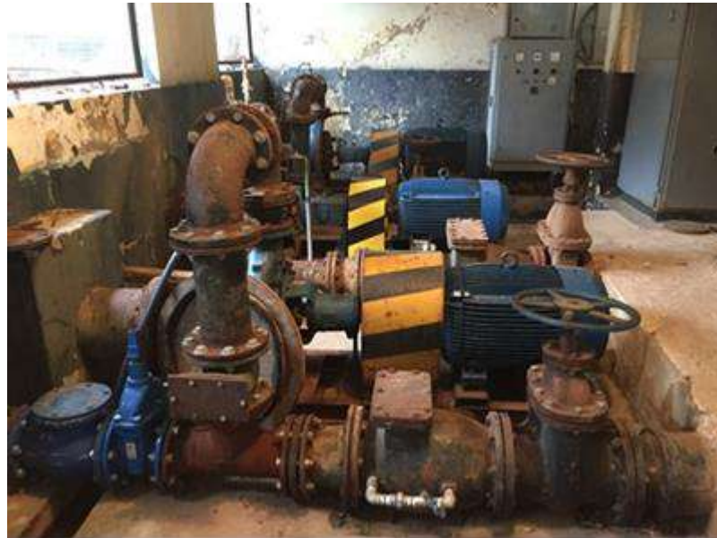
Figura 186 - Vazamento no Recalque de Água Tratada – Sistema Km 35. Fonte: PMSB, 2019.
