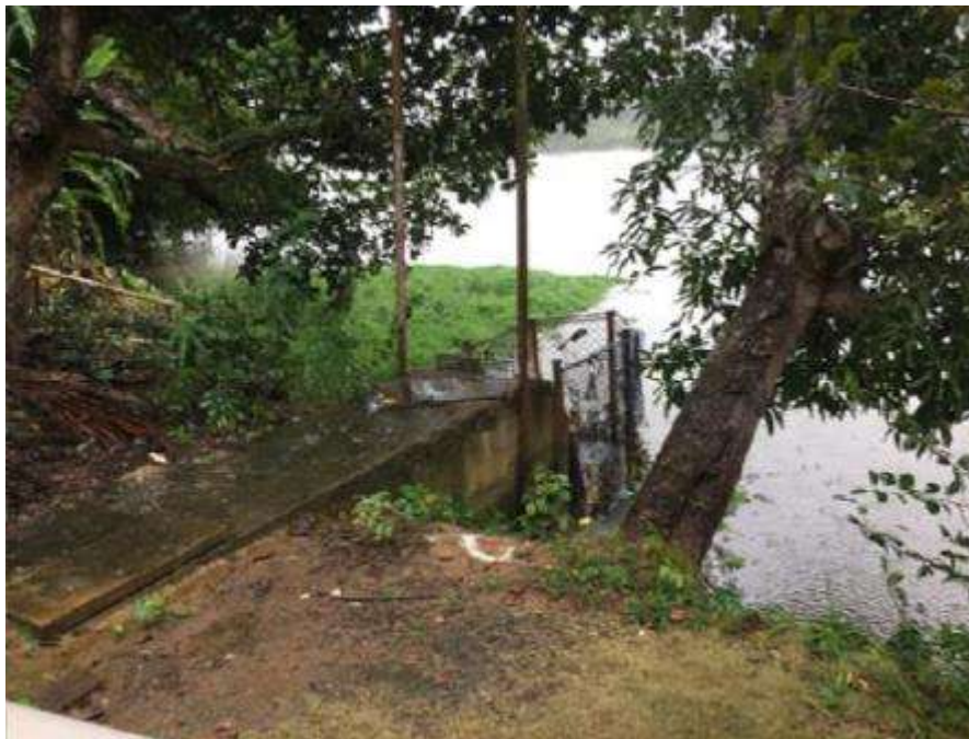
Figura 28 -- Tela Proteção Canal de Captação. Fonte: PMSB, 2019
