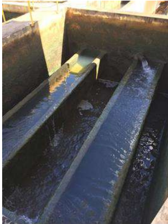
Figura 59 - Filtro Ascendente ETA 1. Fonte: PMSB, 2019.
