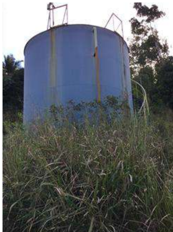
Figura 215 – Reator UASB - ETE Nestor Gomes. Fonte: PMSB, 2019
