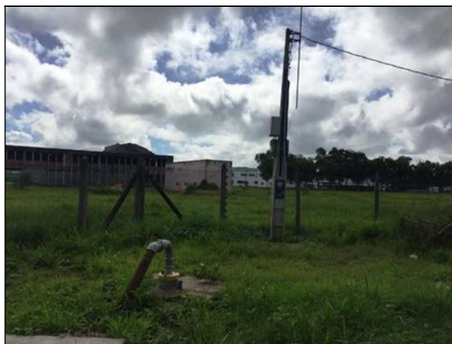
Figura 27 – Poço Principal - Sist. Litorâneo Fonte: Premier Engenharia, 2019.
