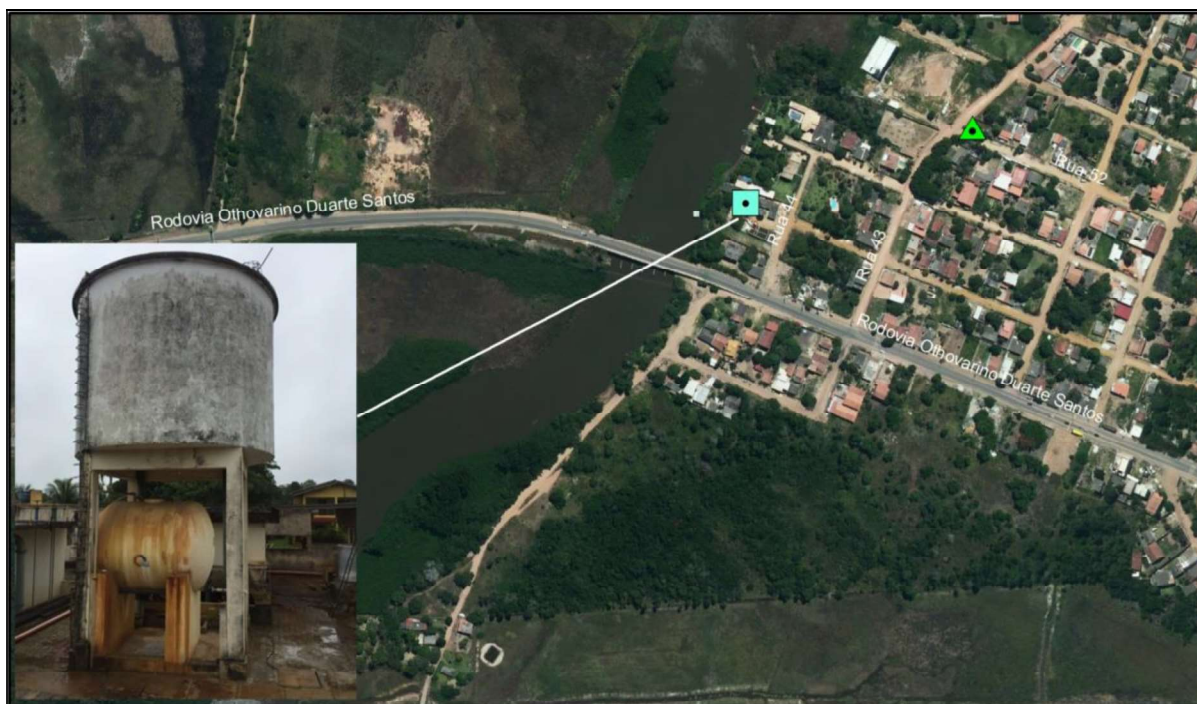
Figura 25 – Reservatório Sist. Guriri
