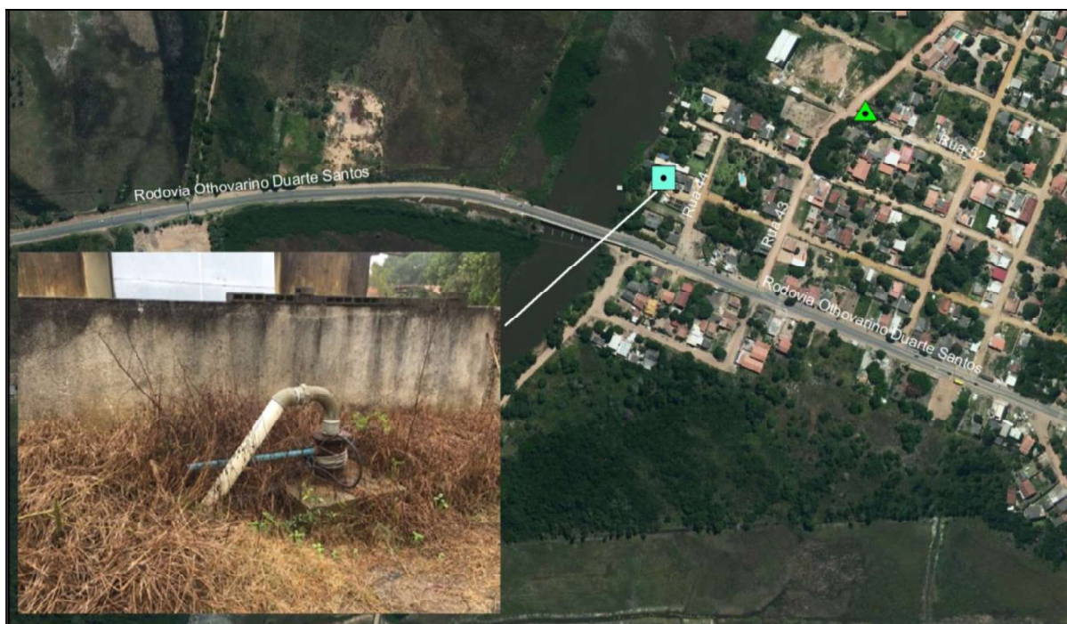
Figura 19 – Poço ETA Guriri Fonte: Premier Engenharia, 2019.
