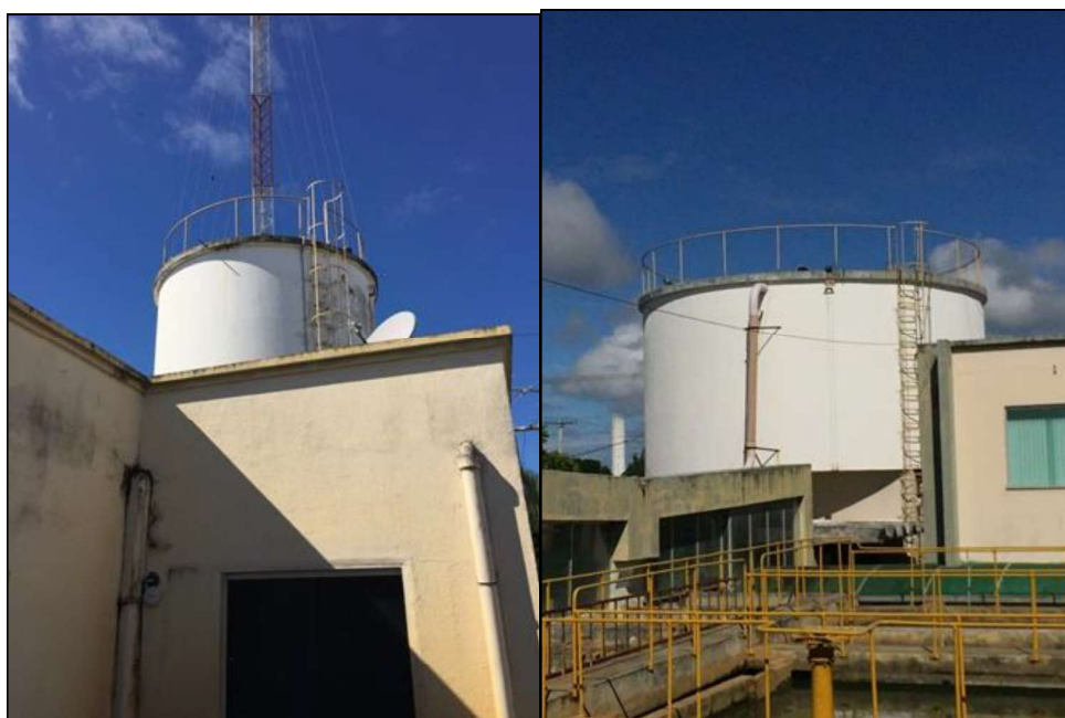
Figura 14 – Reservatórios - ETA's 1 e 2
