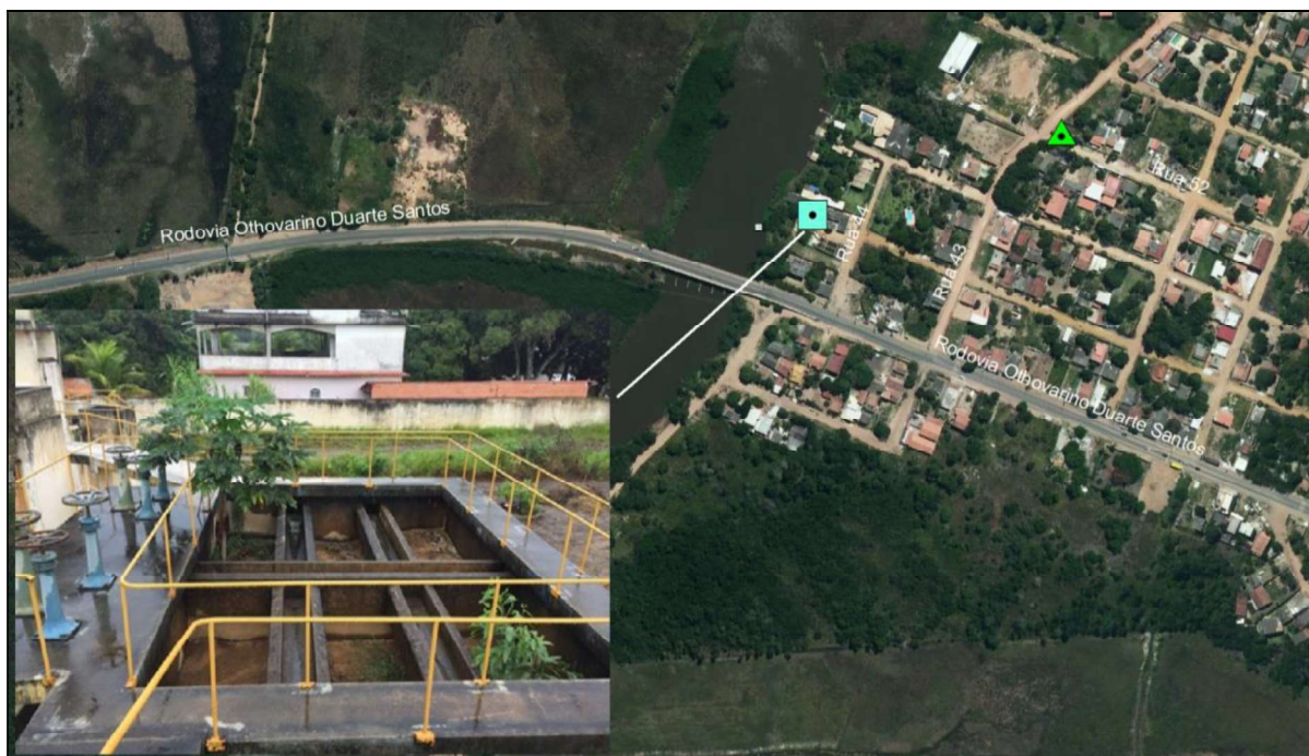
Figura 22 – Localização e detalhe da ETA Guriri Fonte: Premier Engenharia, 2019.
