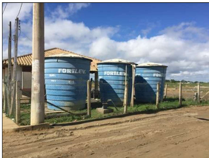
Figura 31 – Reservatórios - Sistema Village Fonte: Premier Engenharia, 2019.
