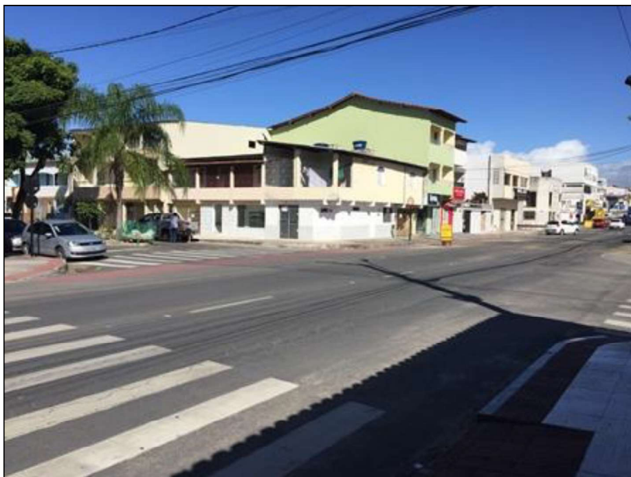
Figura 84 – Área Problema 2: trecho da via suscetível a alagamento Fonte: Premier Engenharia, 2019.
