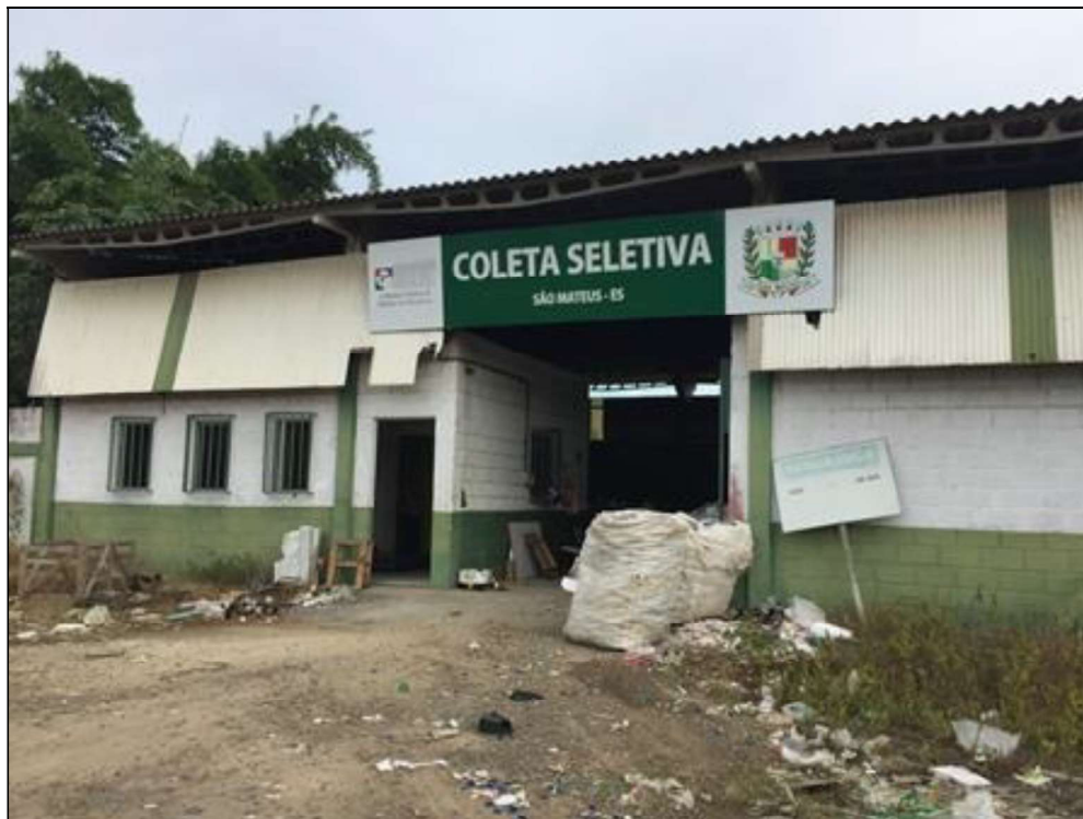
Figura 65 – Sede da Assoc. dos Rec. de Res. Sól. de São Mateus Fonte: : Premier Engenharia, 2019.
