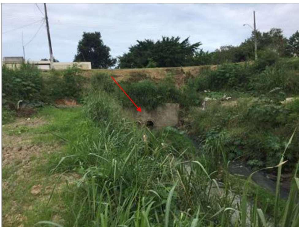
Figura 77 – Vista da passagem do Córrego da Bica sob rodovia Fonte: Premier Engenharia, 2019.
