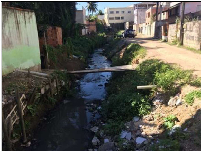
Figura 80 – Área Problema 1: Córrego da Bica (presença de lixo em sua calha) Fonte: Premier Engenharia, 2019.
