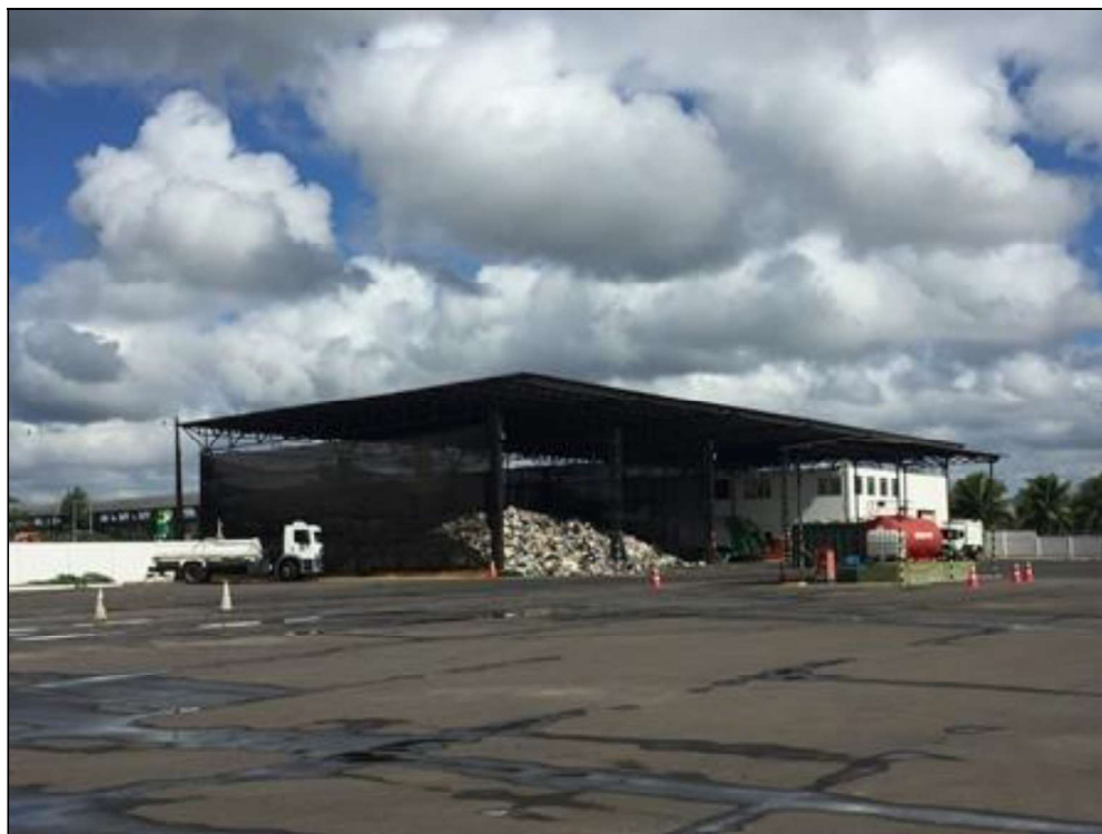
Figura 62 – Estação de transbordo da Empresa Fortaleza Fonte: : Premier Engenharia, 2019.
