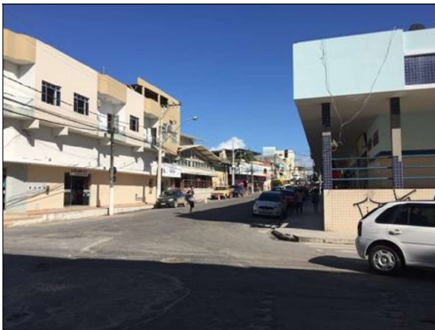
Figura 82 – Área Problema 1: Av. 31 de Março (drenagem deficiente) Fonte: Premier Engenharia, 2019.
